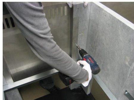
8. Kiinnitä takalevy kahdella ruuvilla
