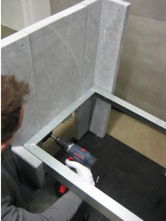
4. Sivukivet kiinnitetään keskikehykseen alapäästä
