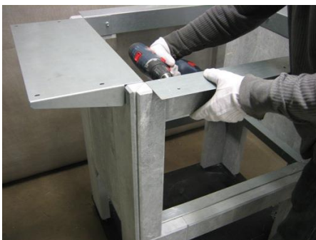
10. Etuyläkiven asennus. Tarkista kivien saumat ja kiristä kaikki ruuvit.
