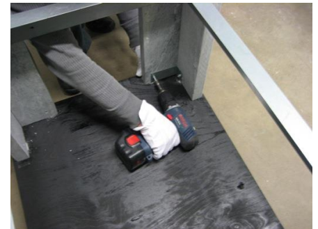
3. Etukulmakivien asennus ja alatuen kiinnitys
