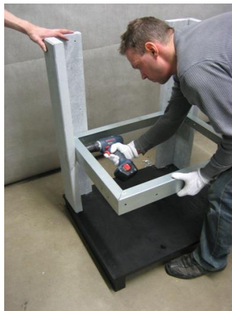
2. Toisten takakulmakivien asennus
